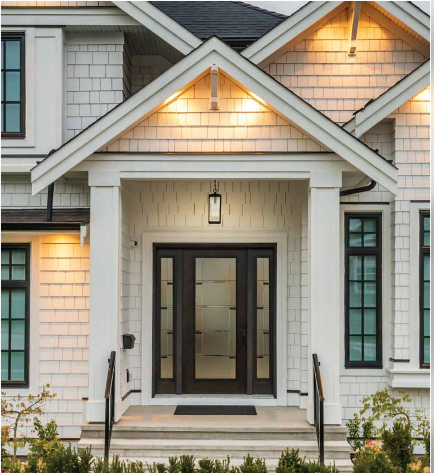
EXTERIOR DOOR OVERVIEW
